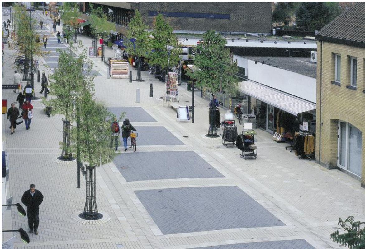
Figur 5.5 Eksempel på gade, hvor betonbelægningssten er benyttet som gennemgående materiale, og kørearealet er markeret med et farveskift (M. D. Madsens Vej, Allerød Kommune) Gaden er ikke shared space men er medtaget som eksempel på belægningsvalg (Foto: Rambøll).
