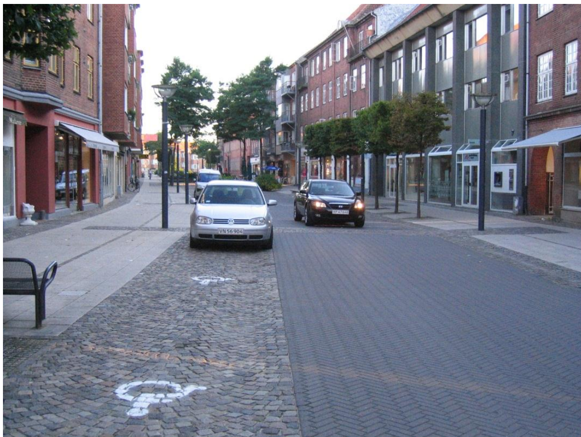
Figur 6.4 Eksempel på en shared space lignende gade med tydeligt markerede gangarealer. I forgrunden parkeringsspor med handicapparkeringspladser. Belægning med chaussésten er dog ikke egnet til dette formål pga. eventuelle udstigende passagerer fra liftvogne (Ringsted) (Foto: Rambøll).
