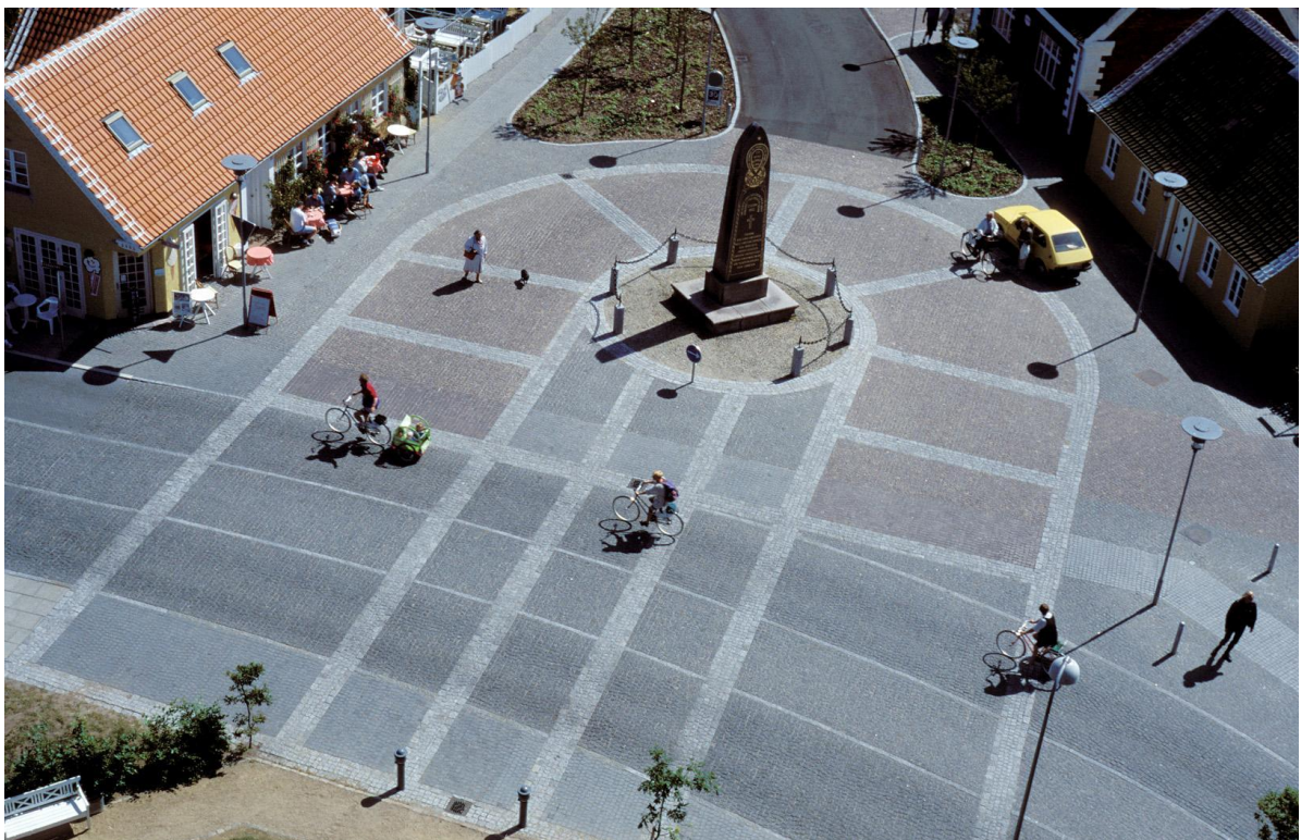
Figur 6.10 Eksempel på et torv ombygget efter shared space principperne (Mindestøttepladsen, Skagen) (Foto: Rambøll).
